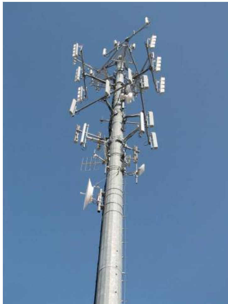
איור 5 בתחנת בסיס מרובת אנטנות משתמשים בדרך כלל בקיטובים מעורבים
